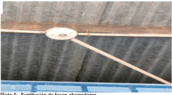
Foto 5: Sustitución de focos ahorradores
