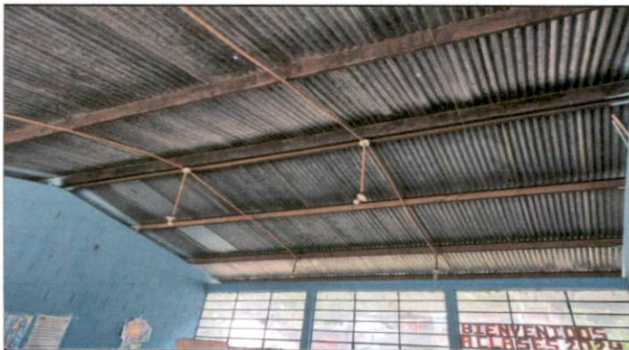
Foto 3: Mantenimiento a estructura de soporte de metal
