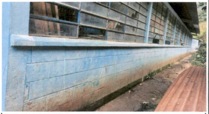
Foto 4: Pintura en muros exteriores e interiores
